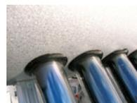
**Nota importante:** Antes de la instalación de los tubos asegúrese éstos no estén expuestos al sol de forma de evitar su expansión, de lo contrario le será difícil introducirlos en las vainas del tanque.
